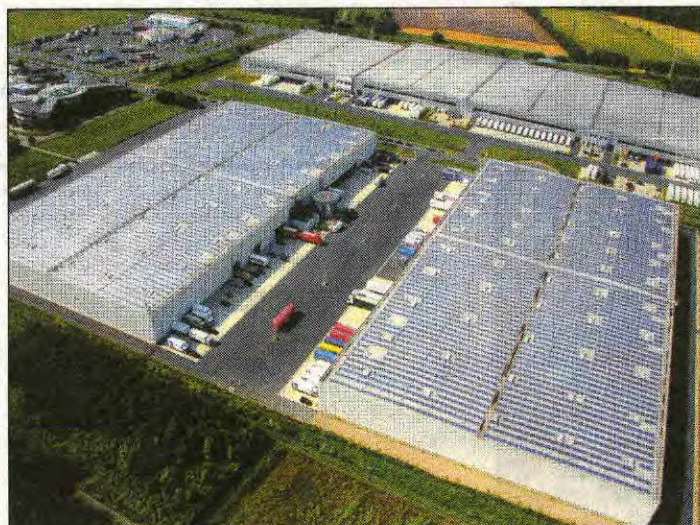
Die Logistikhallen in der Europastraße mit dem Solarkraftwerk.
