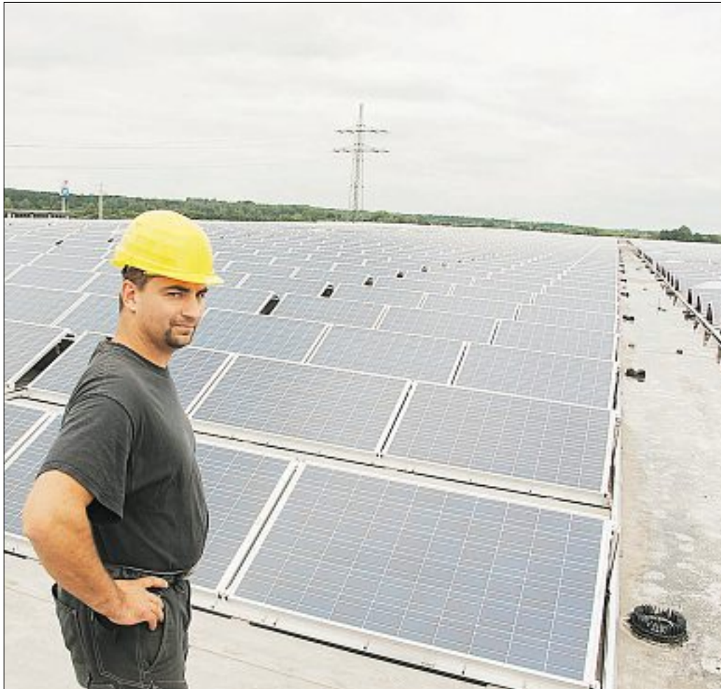
Techniker Daniel Jürgensen begutachtet einen Teil der fast 7000 installierten Solarmodule.
