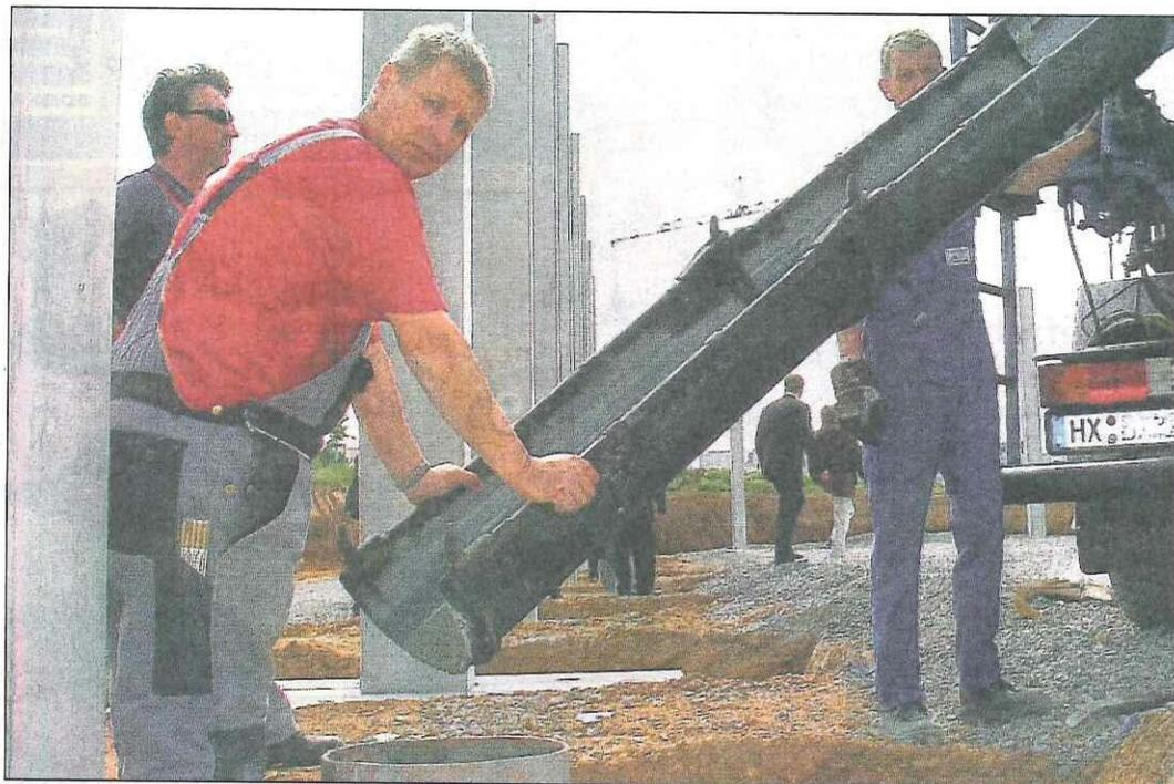
Die ersten Stützen stehen: Monteur Bernd Paege (vorn) von der Firma Sächsische Montagetechnik (SMT) beim Einbetonieren von einem der acht Meter hohen und 7 Tonnen schweren Außenpfeiler, die die Halle tragen.
