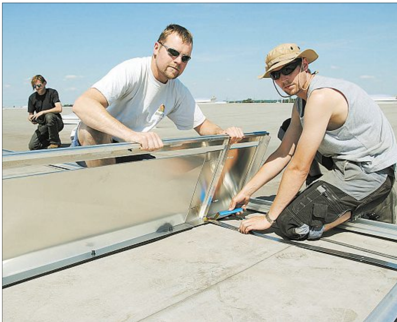
Jörg Lange (von links), Stefan Schulz und Jan Soffner machen auf dem Dach einer Logistikhalle an der Europastraße die ersten Handgriffe. Brunnhöber
